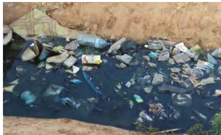
Déchets obstruant les canaux de drainage
